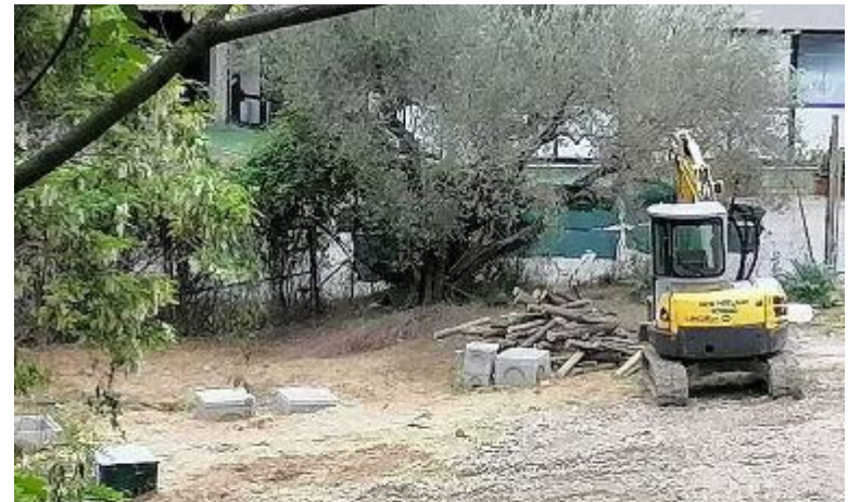
I lavori in corso sul torrente Castellano
