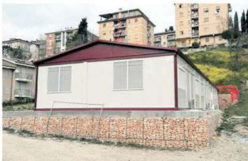
Il prefabbricato donato dal Bim Adige e Trento al Comune di Castignano
