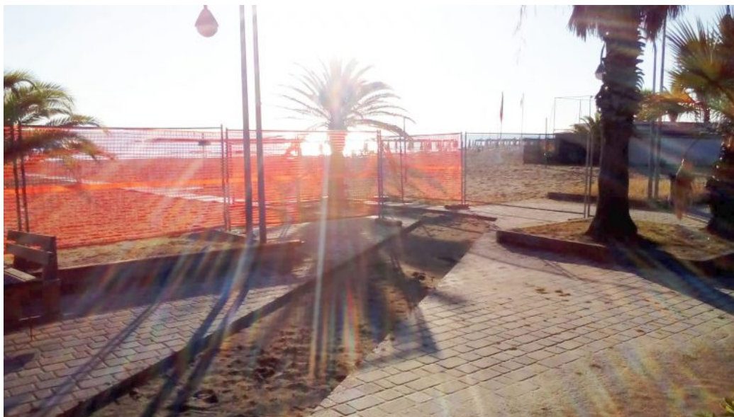
“Spiaggia per tutti” a San Benedetto, lavori in corso per rendere l’arenile accessibile
