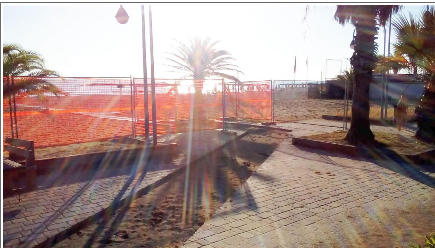
Lavori per l'abbattimento delle barriere sul lungomare
