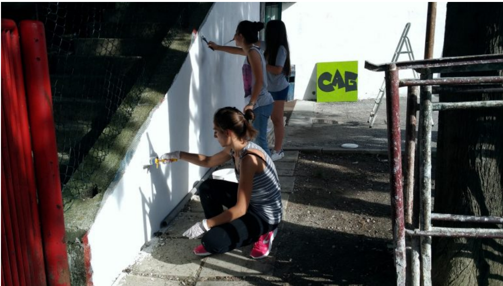
Lavori al “Cag” di Maltignano
