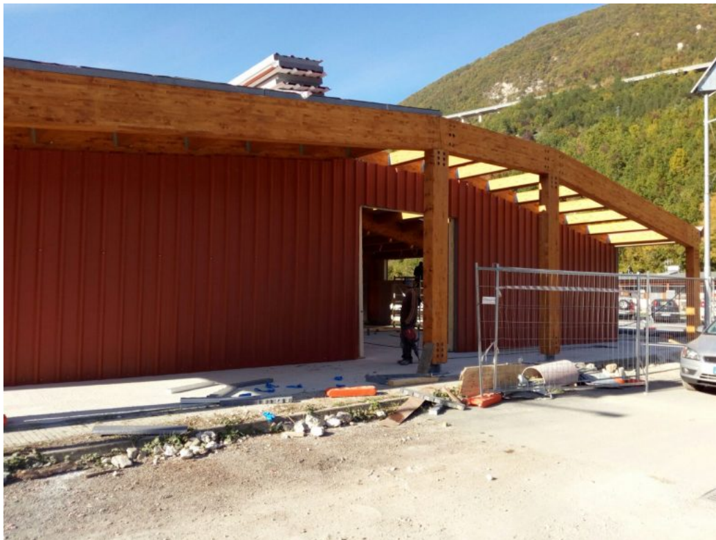
Arquata del Tronto, la Cittadella delle Attività Produttive in fase di costruzione
